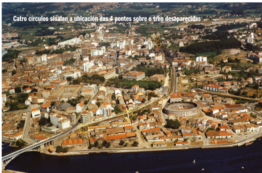
A desembocadura do río dos Gafos
